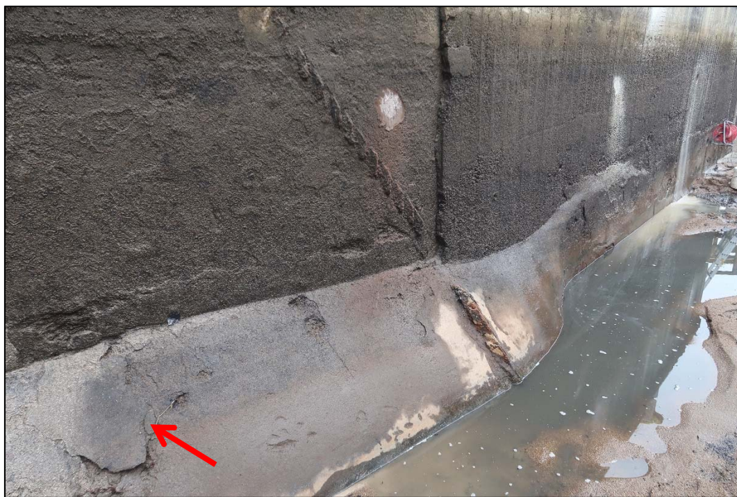
Foto 9: Detailní pohled na odlupující se povrchovou vrstvu betonu
