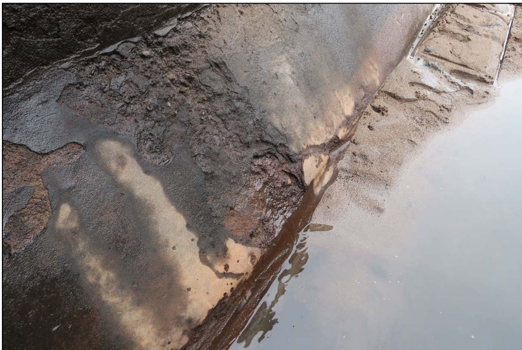
Foto 8: Detailní pohled na chybějící povrchovou vrstvu betonu v náběhu levobřežní zdi náhonu
