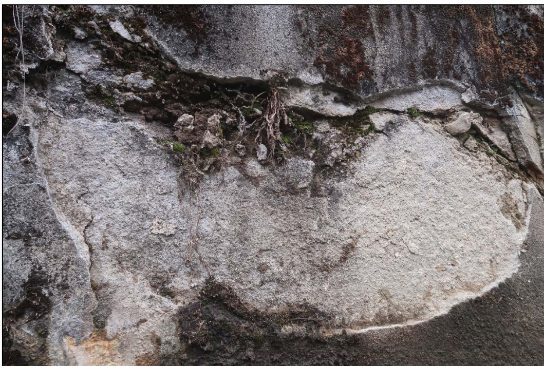
Foto 11: Detailní pohled na odpadlou povrchovou vrstvu betonu; dle laminárního charakteru povrchu lze předpokládat, že dochází k odlupování povrchu historicky provedené stěrky
