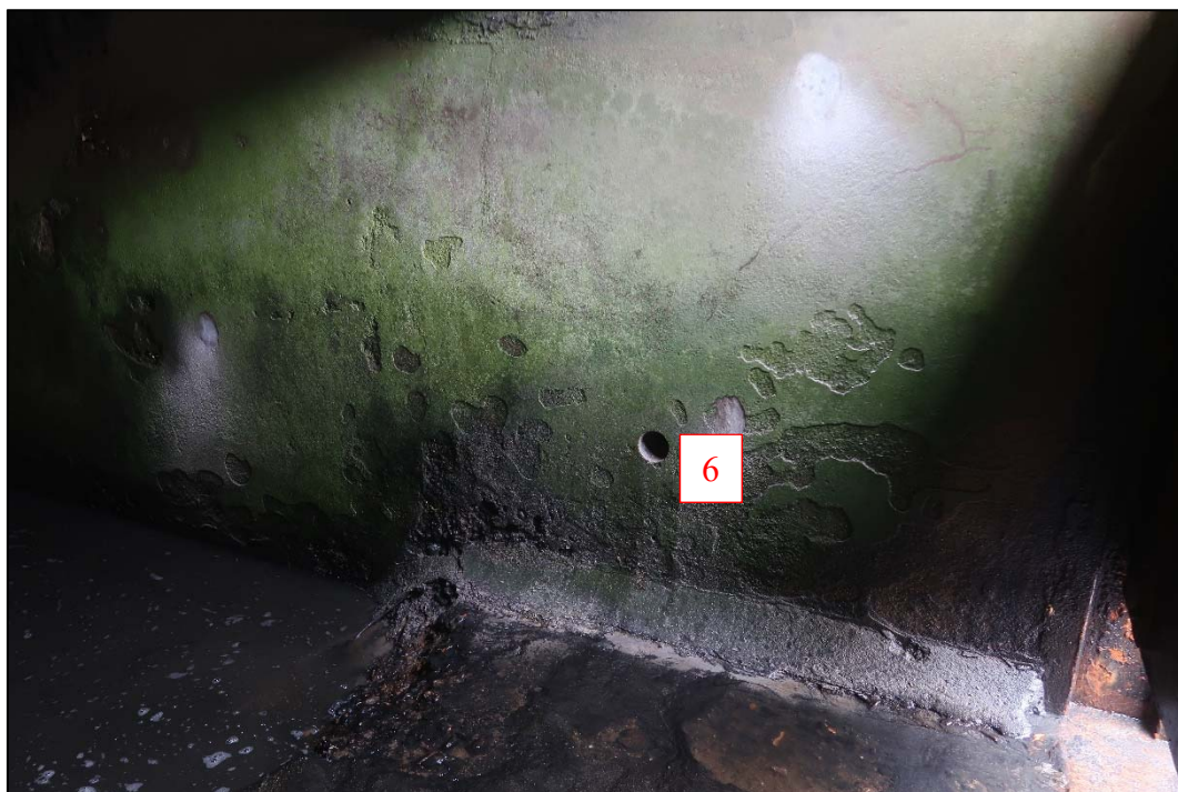
Foto 3: Poloha odběru vývrtnu č. 6 z levé části stěny kašny č. 3 (navazující na zed' náhonu); vývrt proveden na délku vrtací korunky; vývrt 6 proveden ve výšce 0,55m nad přelivnou hranou kašny č. 3
