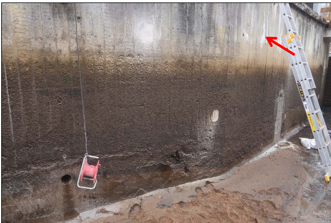
Foto 12: Pohled na spodní líc střední části stěny s patrným rozsahem mezi „suchou“ a „mokrou“ částí zdi a otisky prkenného bednění; v patě patrné odlupující se povrchové vrstvy betonu a šterkové hnízdo (detail viz Foto 13); červenou šipkou označena oblast s patrným vápenným výluhem pojiva v první třetině stěny
