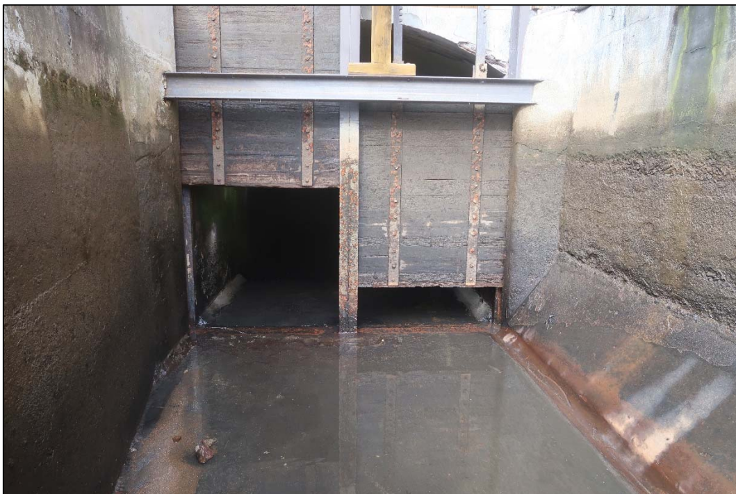
Foto 5: Celkový pohled na stavidlo u kašny č. 3; na fotografii patrné rozhraní mezi „suchou“ a „mokrou“ částí zdi
