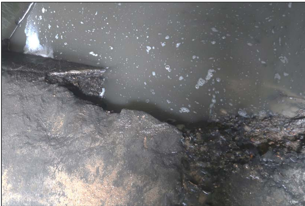
Foto 21: Detailní pohled na degradovanou přelivnou hranu kašny č. 3; na fotografii viditelný chybějící kus hrany
