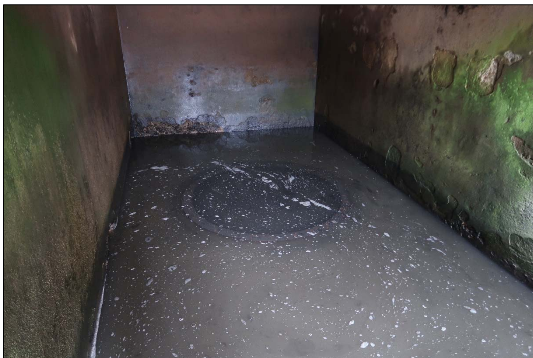
Foto 25: Celkový pohled na dno kašny č. 3; v čelní stěně patrné degradované a chybějící povrchové vrstvy betonu
