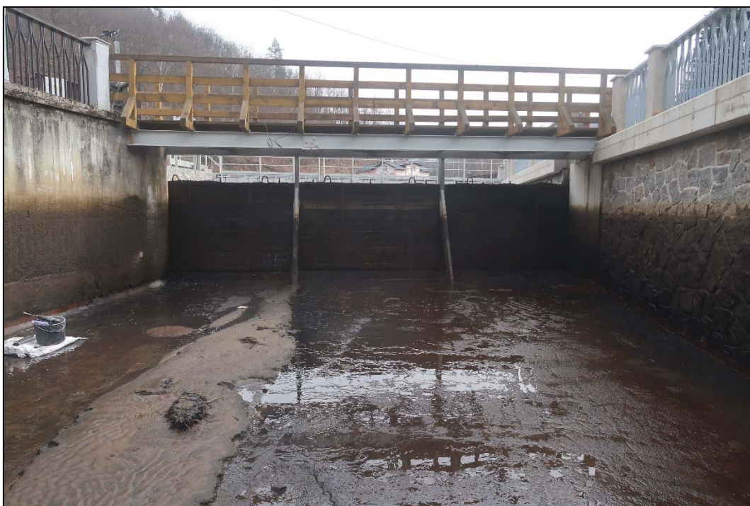
Foto 6: Celkový pohled na stavidlo u lávky – směrem k jezu; na fotografii patrné rozhraní mezi „suchou“ a „mokrou“ částí zdi a otisky prkenného bednění
