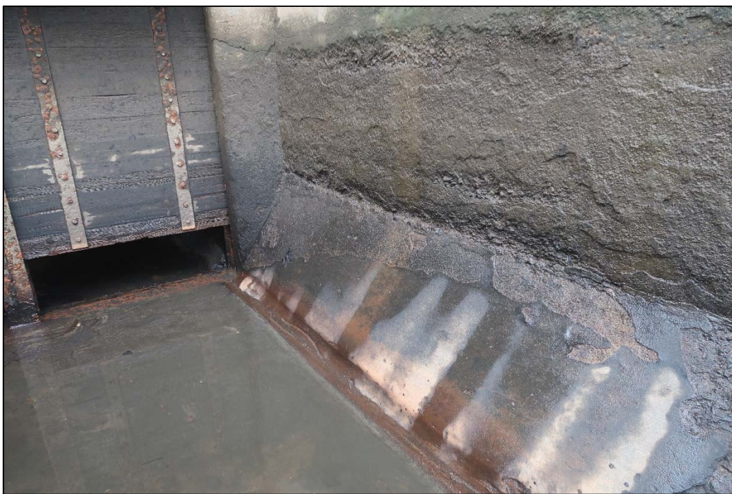
Foto 16: Detailní pohled na náběh v patě levobřežní zdi náhonu; na fotografii patrná degradace povrchových vrstev betonu
