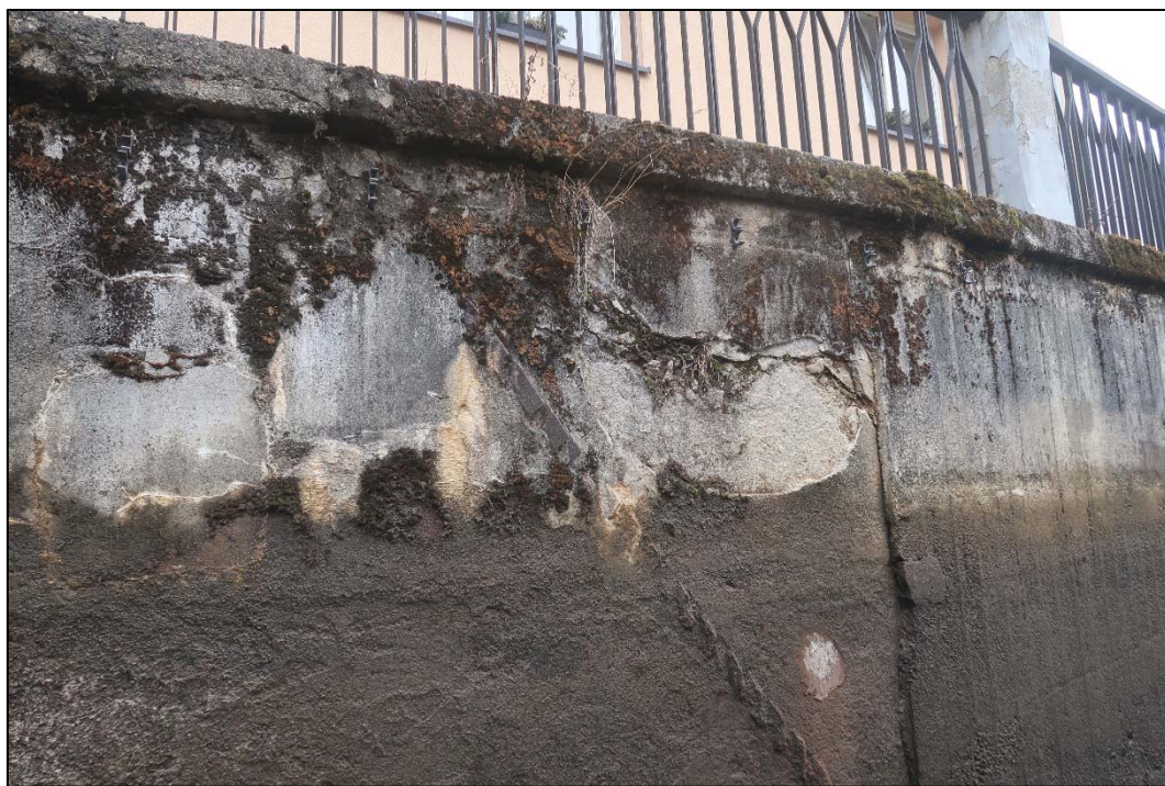
Foto 10: Pohled na poslední třetinu levobřežní zdi náhonu; na fotografii patrná degradace povrchových vrstev betonu se sítí všesměrných trhlin; dle detailu na následující fotografii se může jednat o historicky provedenou stěrku
