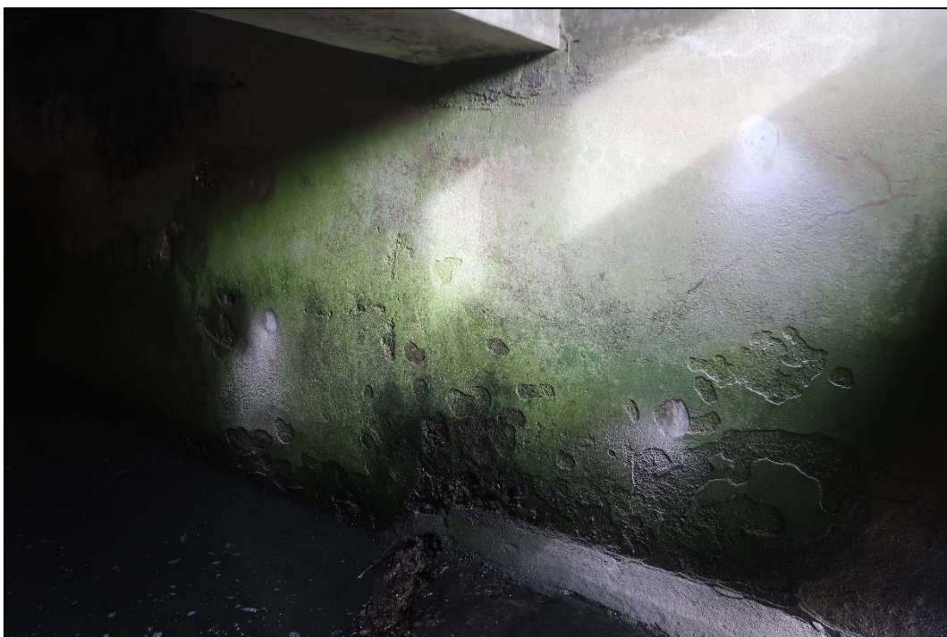
Foto 19: Celkový pohled na stěnu kašny navazující na levobřežní zeď náhonu malé vodní elektrárny v Lokti; na fotografii patrná degradace povrchových vrstev betonu
