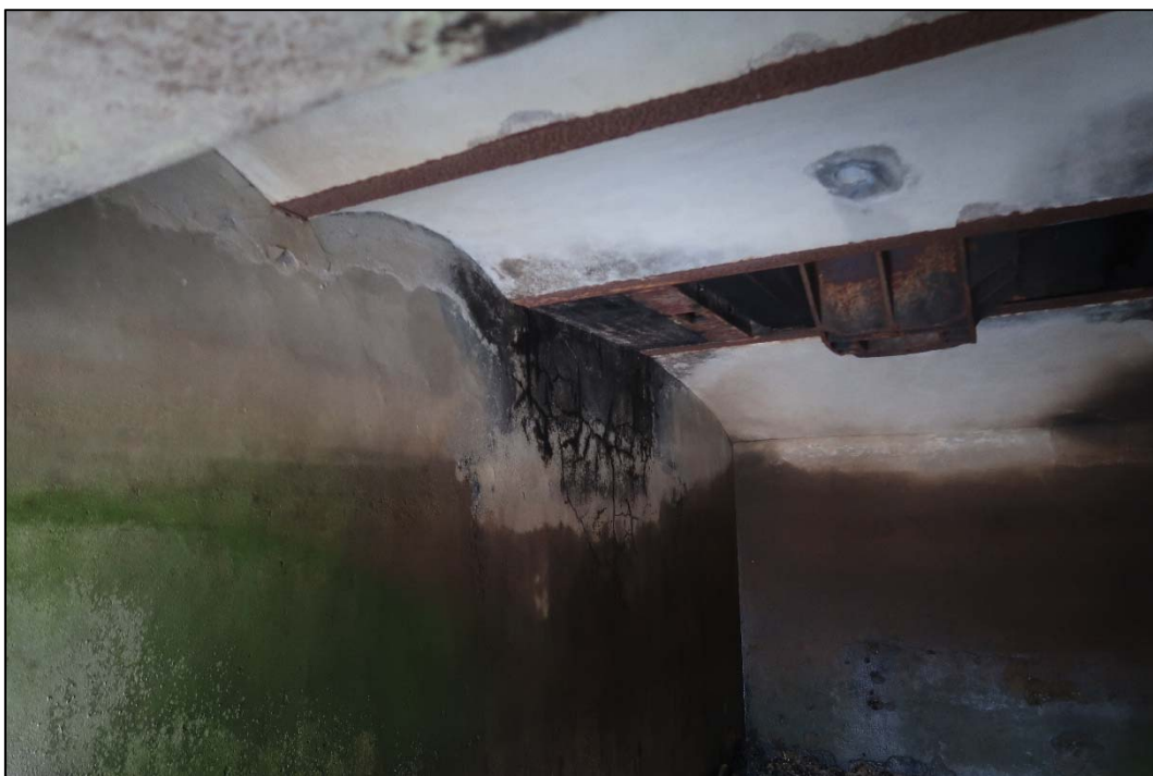
Foto 23: Celkový pohled na zastropení kašny č. 3 za příčným průvlakem (viz foto 20); strop tvořen klenbami do ocelových profilů; pod stropem patrná oblast degradace povrchových vrstev betonu a všesměrná síť trhlin
