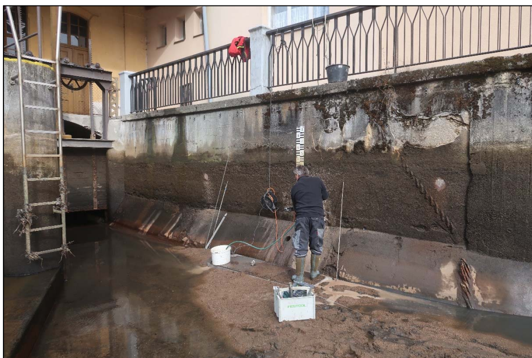
Foto 4: Celkový pohled na levou část betonové zdi náhonu; na fotografii patrné rozhraní mezi „suchou“ a „mokrou“ částí zdi; patrný náběh pod stěnou
