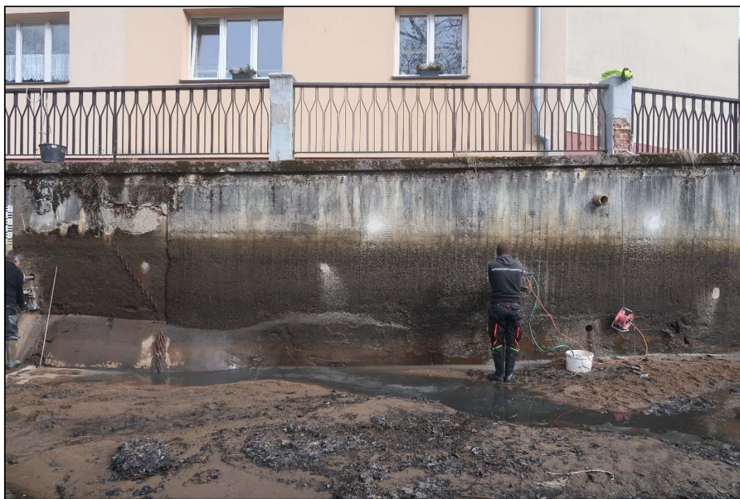
Foto 3: Celkový pohled na střední část betonové zdi náhonu; na fotografii patrné rozhraní mezi „suchou“ a „mokrou“ částí zdi a otisky prkenného bednění; v levé části patrný náběh pod stěnou
