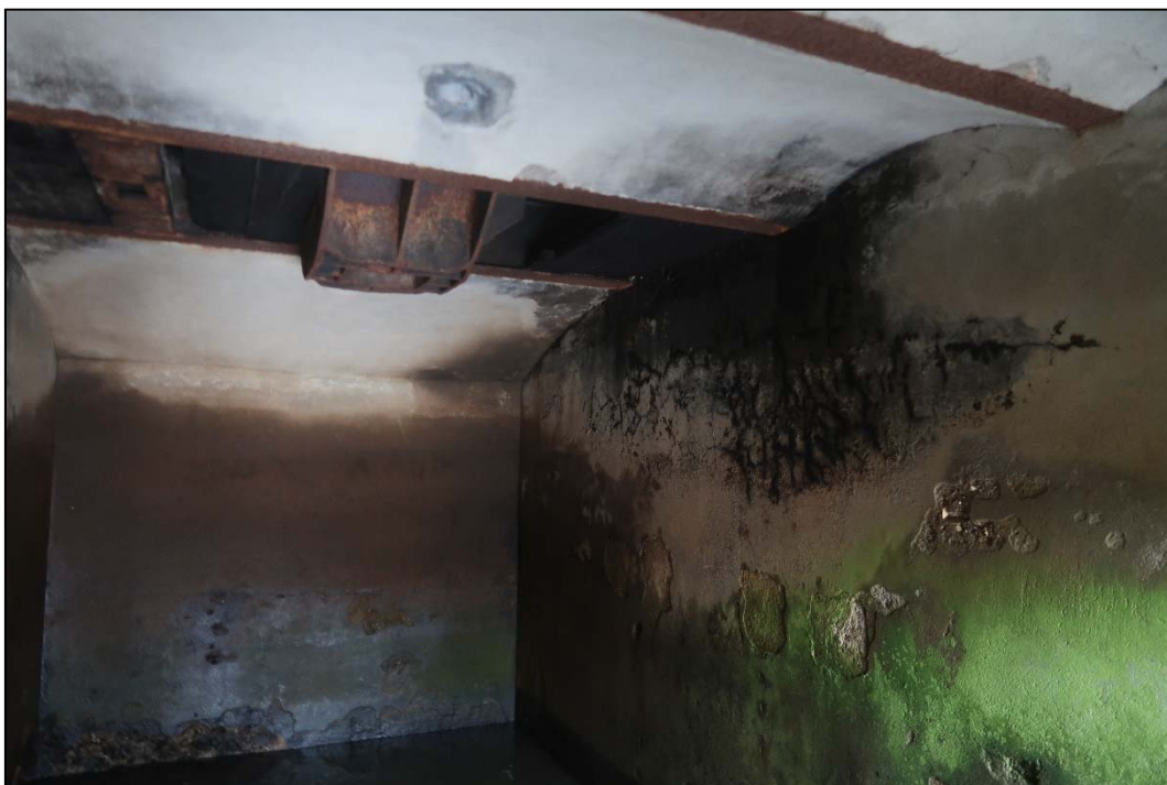
Foto 24: Celkový pohled na zastropení kašny č. 3 za příčným průvlakem (viz foto 20); strop tvořen klenbami do ocelových profilů; pod stropem patrná oblast degradace povrchových vrstev betonu a všesměrná síť trhlin
