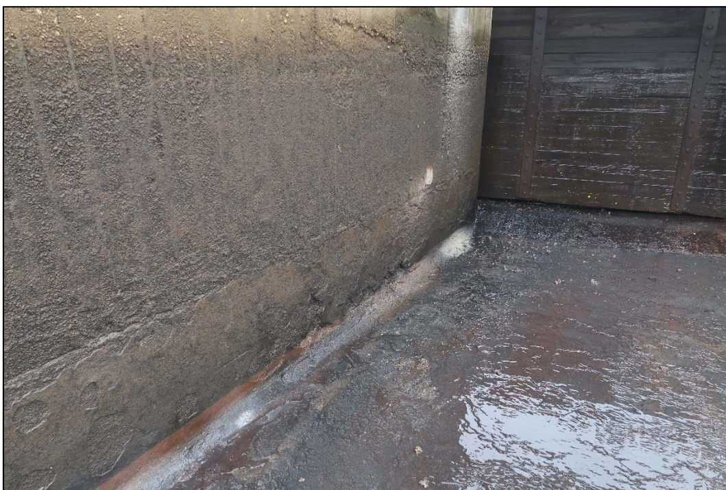
Foto 14: Pohled na patu první části stěny; na fotografii patrná degradace povrchových vrstev betonu
