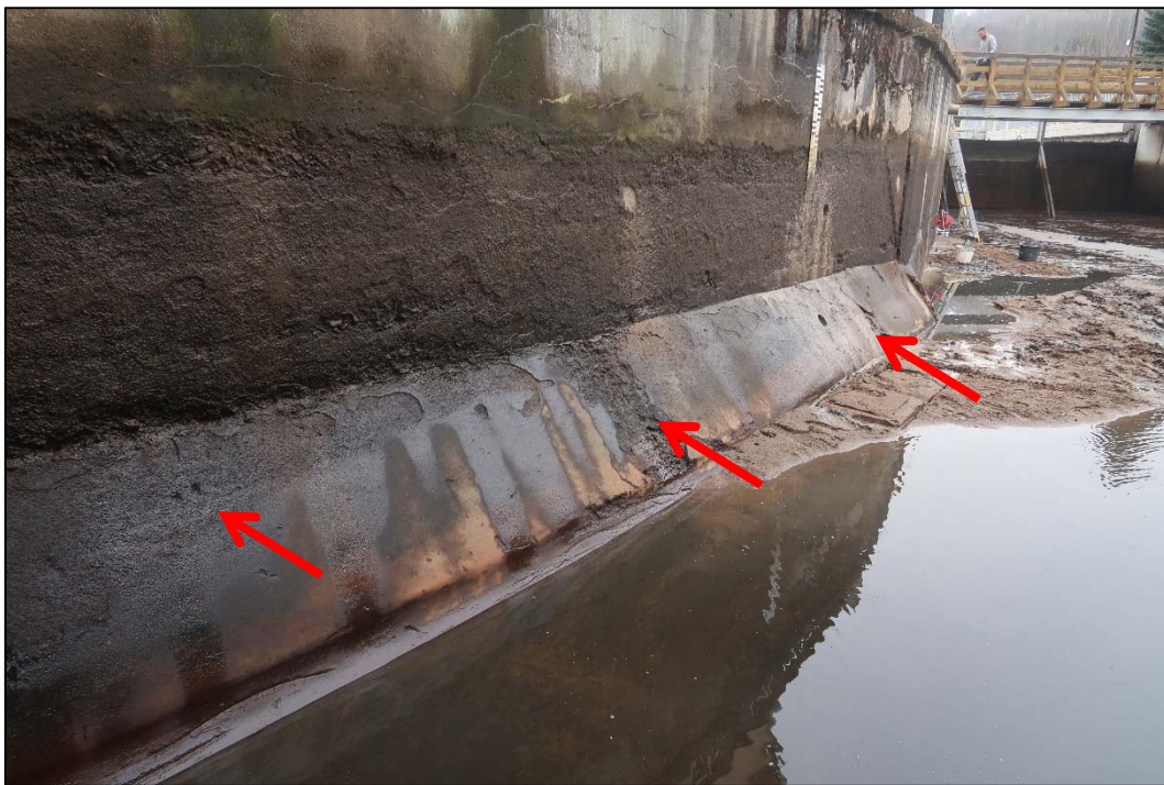
Foto 7: Celkový pohled na náběh v patě levobřežní stěny náhonu v poslední třetině délky stěny; na fotografii patrné oblasti s degradovanou povrchovou vrstvou betonu – označeno červenou šipkou
