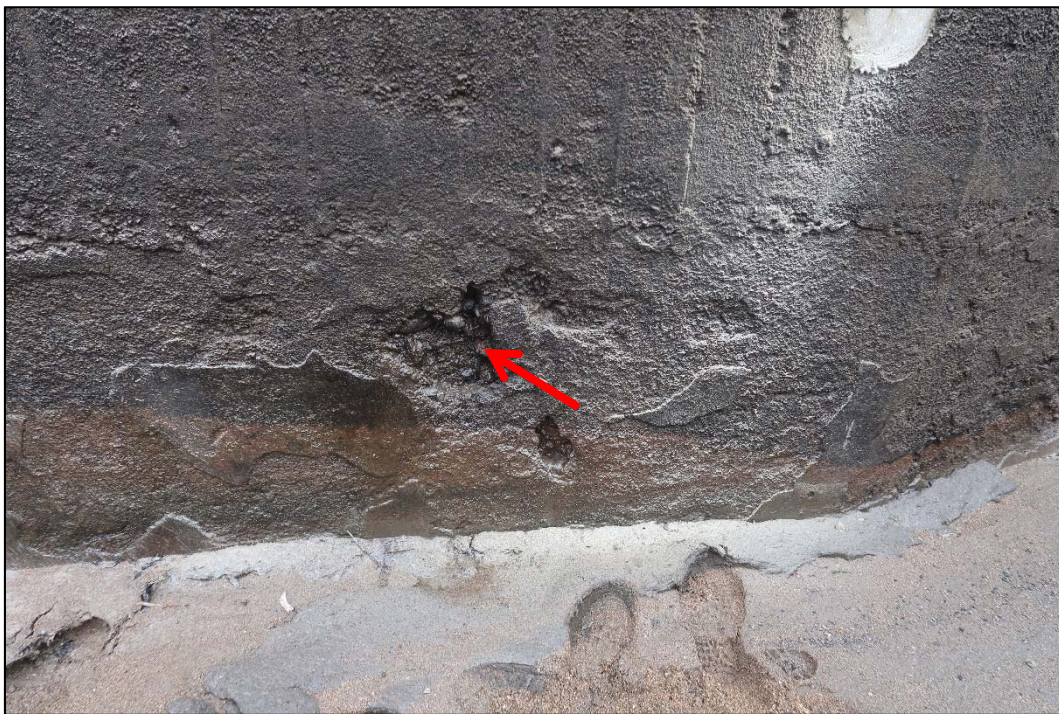
Foto 13: Detailní pohled na degradovanou povrchovou vrstvu betonu s patrným štěrkovým hnízdem (označeno červenou šipkou)
