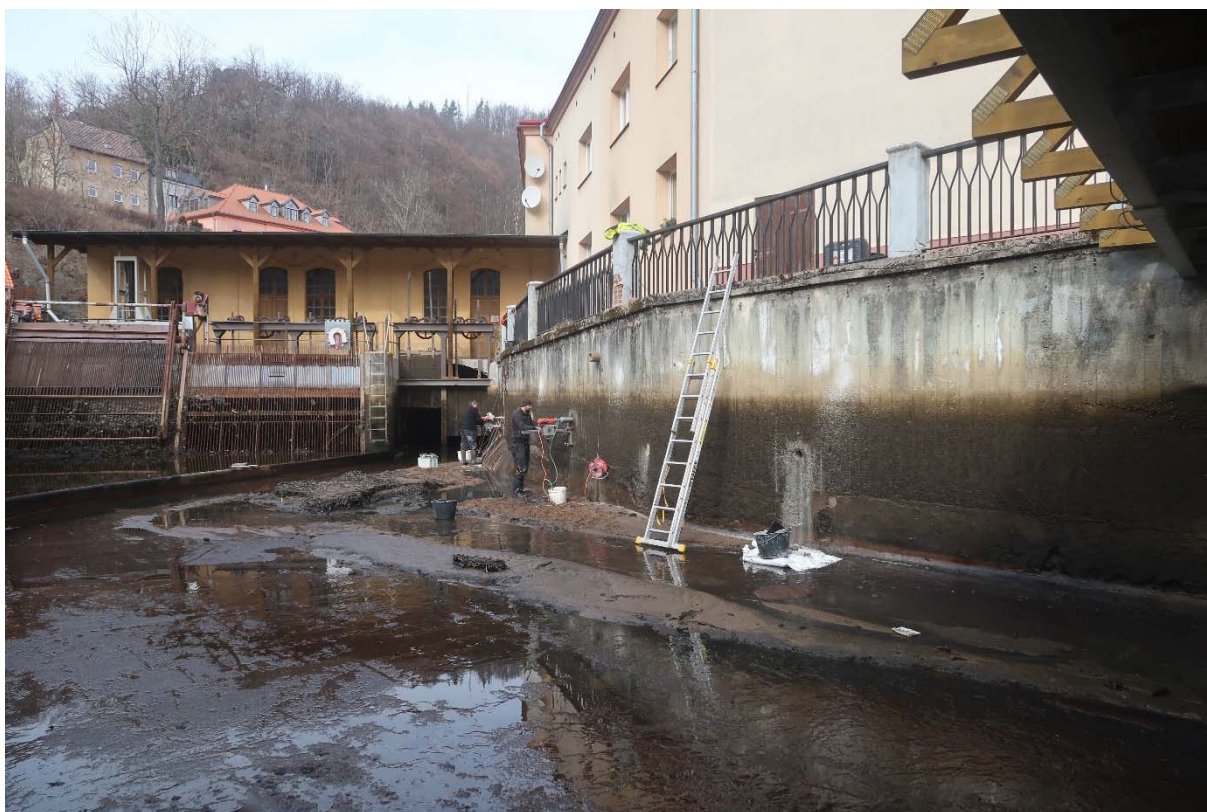
Obr. 1: Celkový pohled na řešenou část levobřežní betonové stěny náhonu malé vodní elektrárny v Lokti
