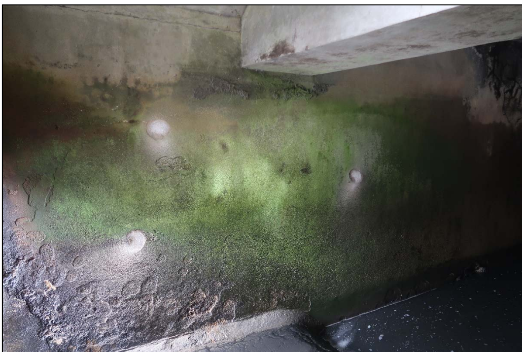
Foto 20: Celkový pohled na protější stěnu kašny; na fotografii patrná degradace povrchových vrstev betonu a příčný průvlak
