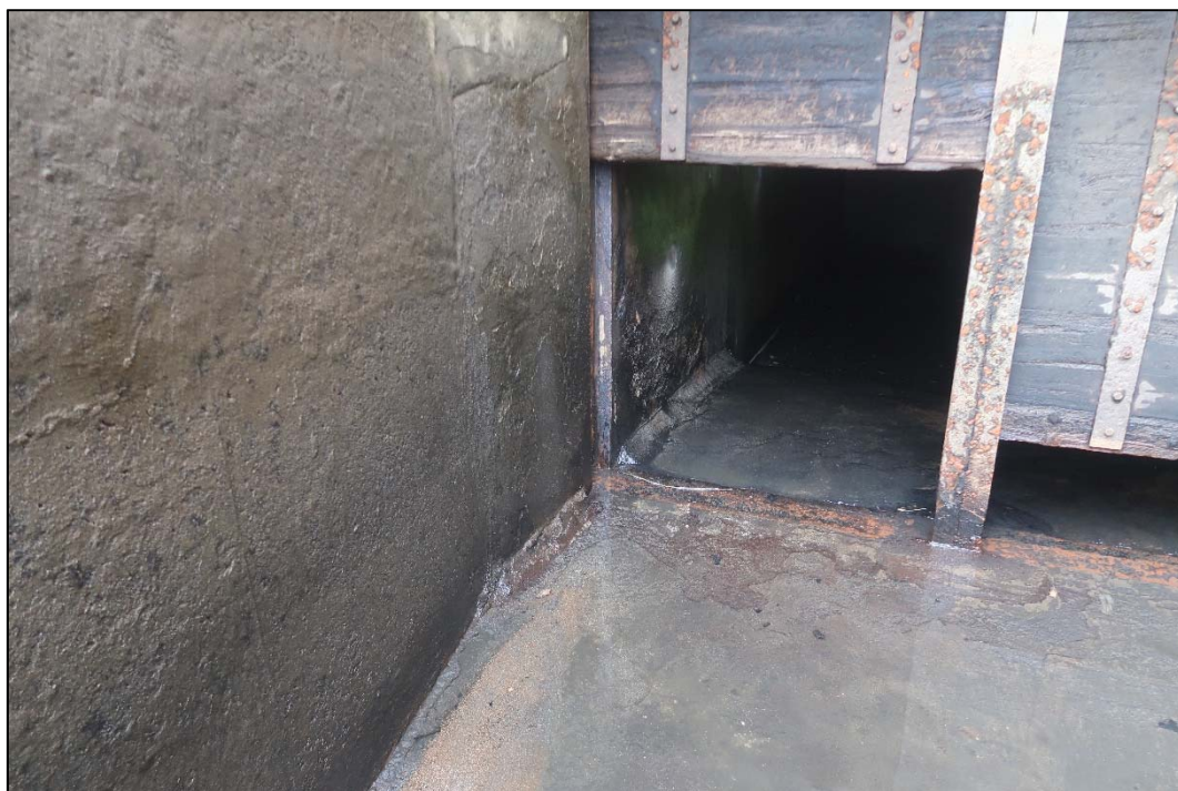
Foto 17: Detailní pohled na návodní stěnu před stavidlem kašny č. 3; na fotografii patrná degradace povrchových vrstev betonu
